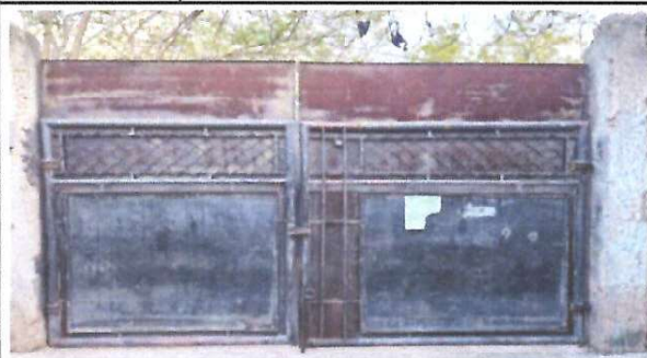
Sustitucion de portón de ingreso
