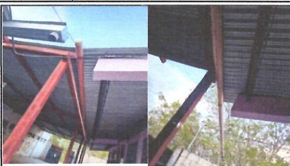
Reparacion de pared agrietada de cocina y sustitucion de canal con bajadas pluviales
