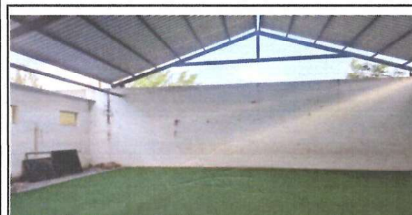
Apicacion de pintura en muros interiores y exteriores
