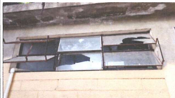
Sustitución de ventanas de metal y vidrio por ventanas de PVC
